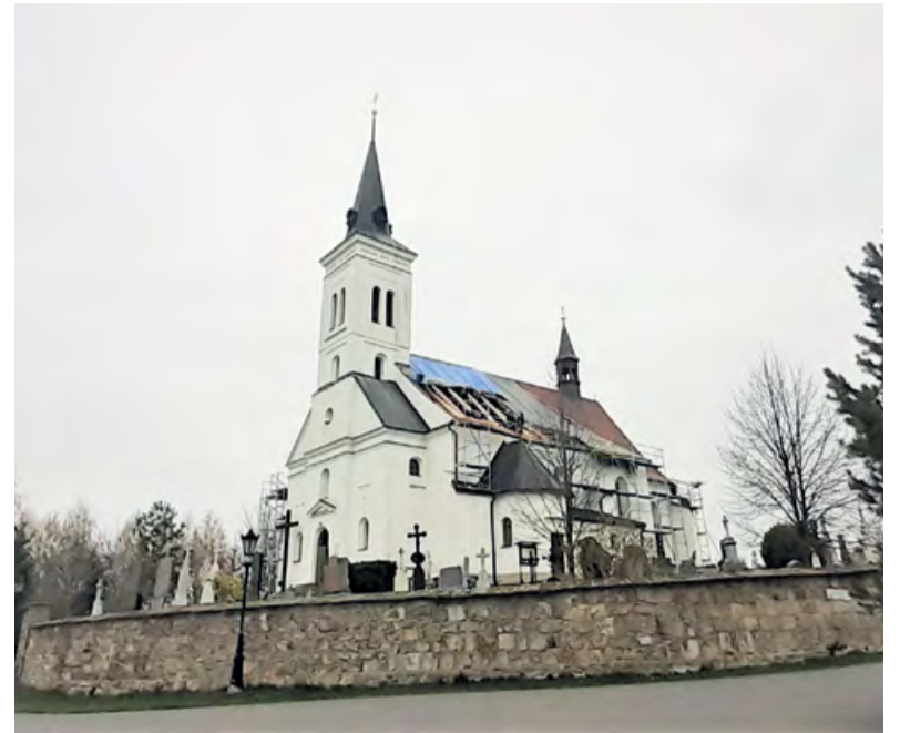
Rekonstrukce střechy probíhala od dubna do července.
