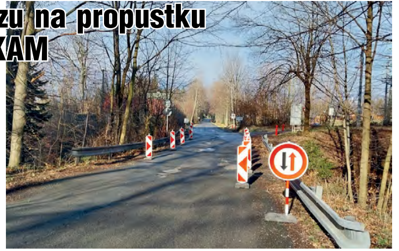
Komunikace pod hotelem KAM zúžená do jednoho jízdního pruhu.
